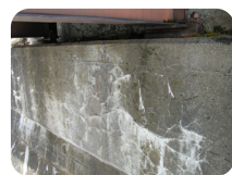
近接目視・写真撮影
